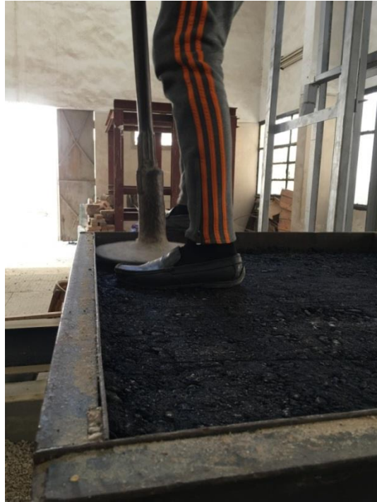
Fig.5. Asphalt layer formation
